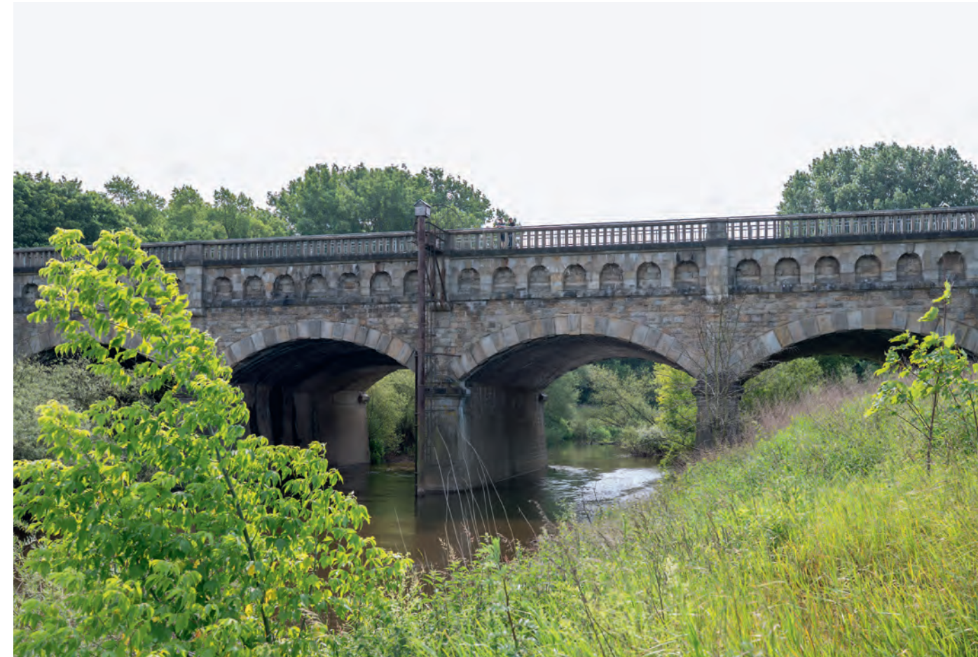
Ein ansprechendes Industriedenkmal aus der wilhelminischen Zeit mit Ibbenbürener Sandstein am aufgehenden Mauerwerk
